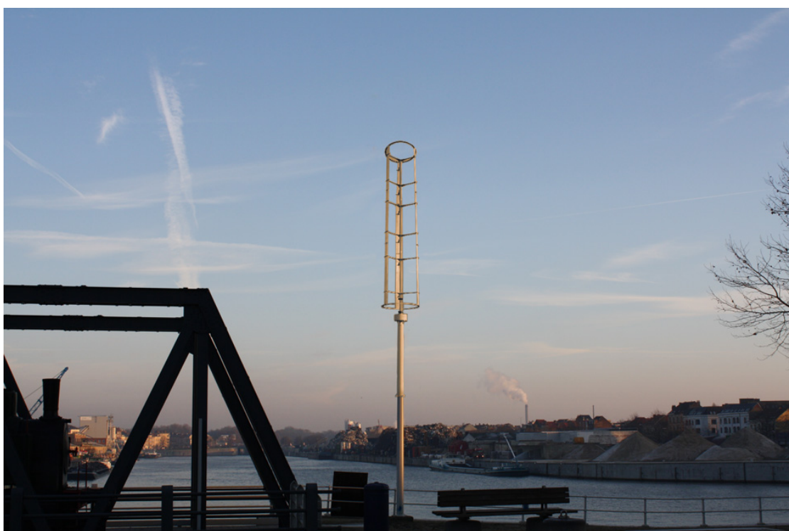
Figuur 7.24: Mockup van de Windspire in de Haven van Brussel met een hogere ashoogte
